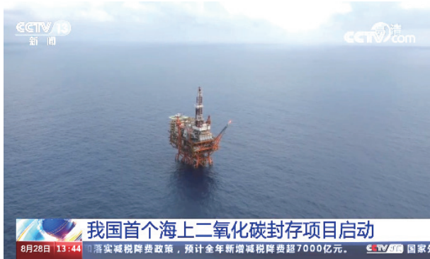
图2 计划开展离岸CO 2 封存示范项目的中国海油恩平15-1 油田群海上平台
