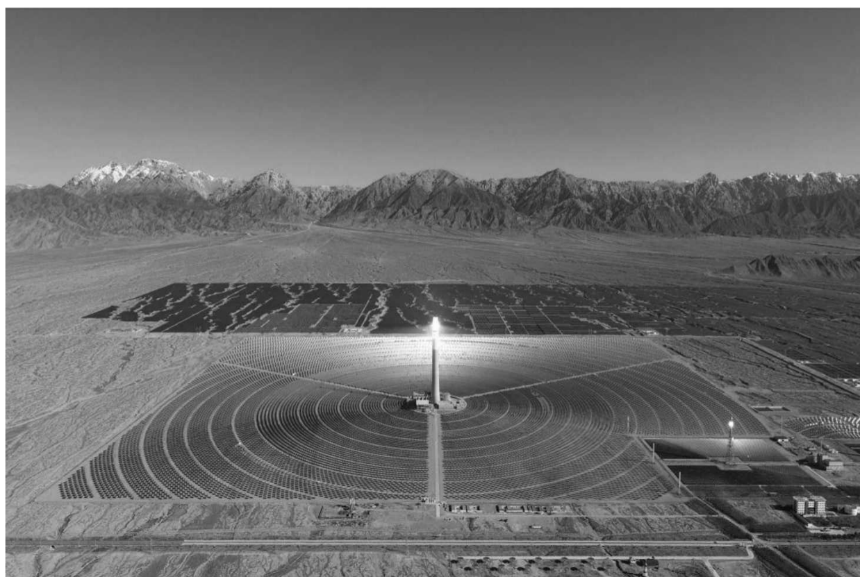
图3-14 中控太阳能德令哈光热发电项目全景图
